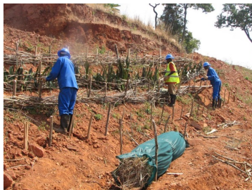
图 7.22 几内亚 Alufer Bel Air 的斜坡稳定措施
