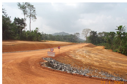
图 7.23 几内亚 Alufer Bel Air 临时和永久侵蚀控制
