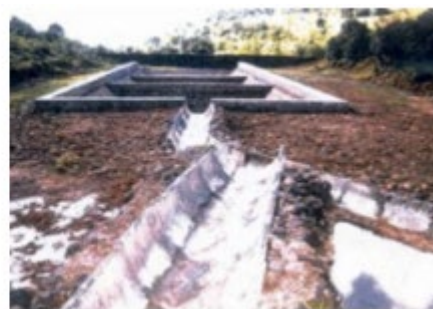
图 7.2 印度 Hindalco Durgmanwadi 的淤泥系列坝和沉积池中的淤泥
